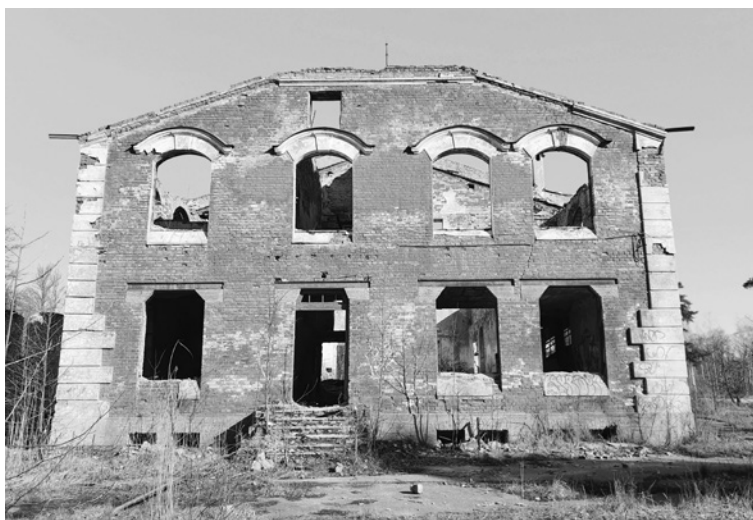
Бывшее здание электрической станции Александрии
