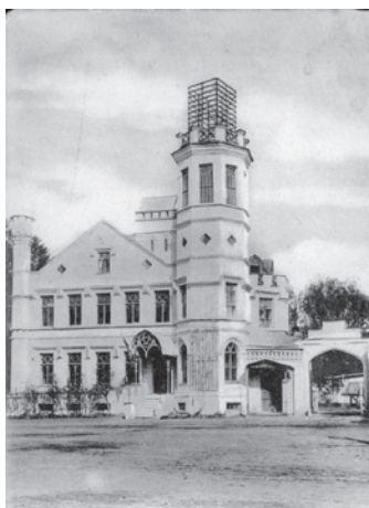
Здание телефонной станции в Петергофе на Петербургской улице
