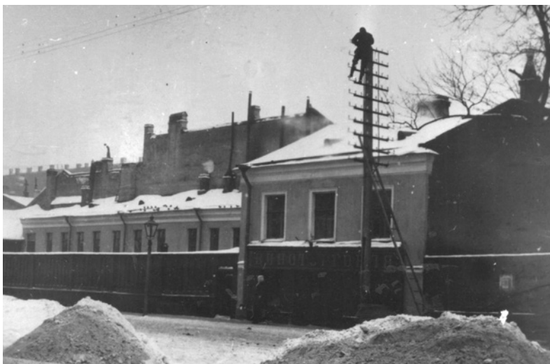
Ремонт надсмотрщиком телефонной линии
