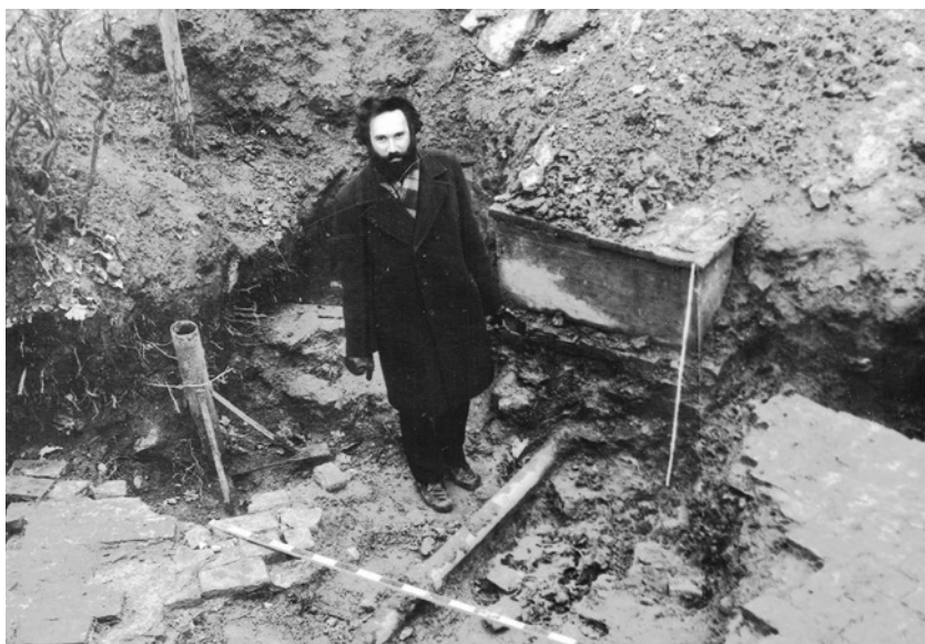
Раскопки Нишельного фонтана («О Змии») на Морском канале 1981
